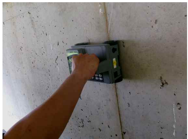
철근탐사 시험 현황
